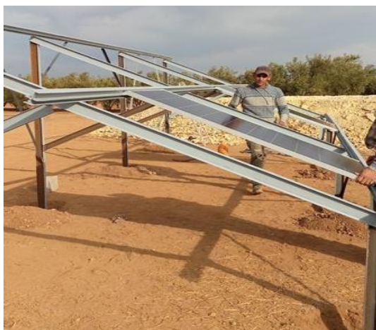
Mise en place de la structure des panneaux du forage 4
