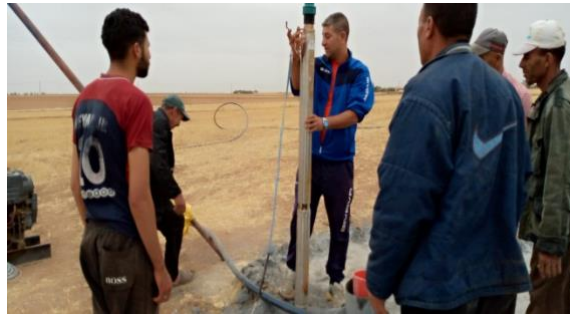
Mise en place des pompes immergées
