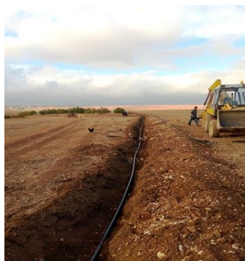
Réalisation des tranchées et la pose des tuyaux
