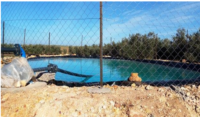
Bassin de 250 M3 avec la pompe de refoulement et le grillage
