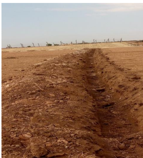
Réalisation des tranchées et la pose des tuyaux
